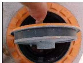
Spill bucket lid gasket
