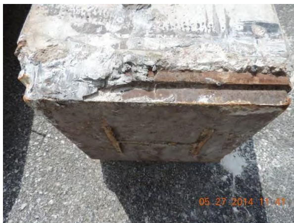
Fig. 79 – W8x40 base plate
