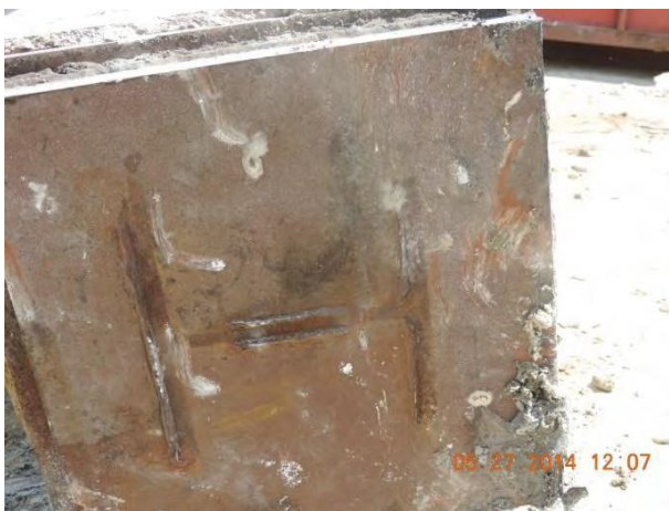
Fig. 81 – W8x40 base plate
