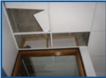
AIB fire stop over door
